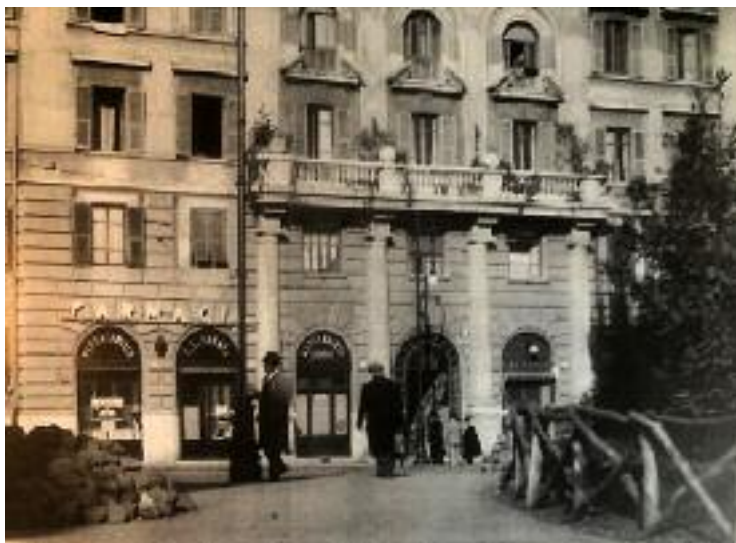
Lavori in corso, 1930 c. (lato Farmacia)
