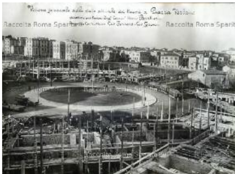
Visione generale dello stato dei lavori a Piazza Verbano, 1930 c
