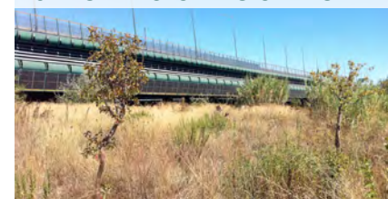
10 - PONTE CASTEL GIUBILEO
