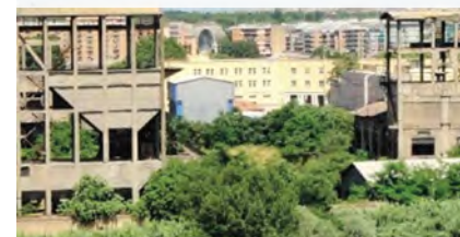
10 - AREA INDUSTRIALE DISMESSA
