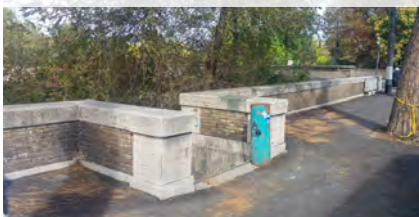
2 - SCALA DI ACCESSO
