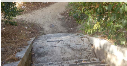
4 - SCALA DI ACCESSO
